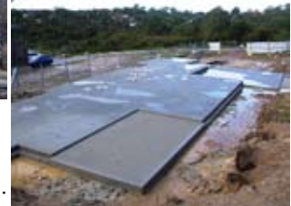
コンクリ土台完成。 濡らすと強度向上するとは…
