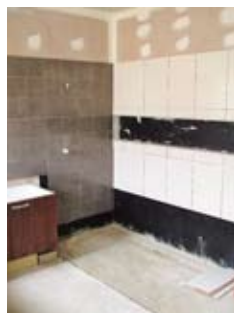
前回以降も建築は順調に進んで、Bathroomはタイル張られてそれらしくなってきた。
